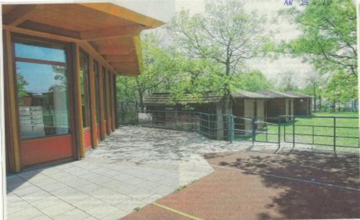
Die Elisabethschule in Aichach braucht mehr Platz. Der Verein Lebenshilfe Aichach-Friedberg will das Förderzentrum mit einem Neubau und einem Umbau erweitern. We jetzt noch die drei Holzgebäude stehen, soll ein Neubau entstehen. Foto: Erik Ehler
